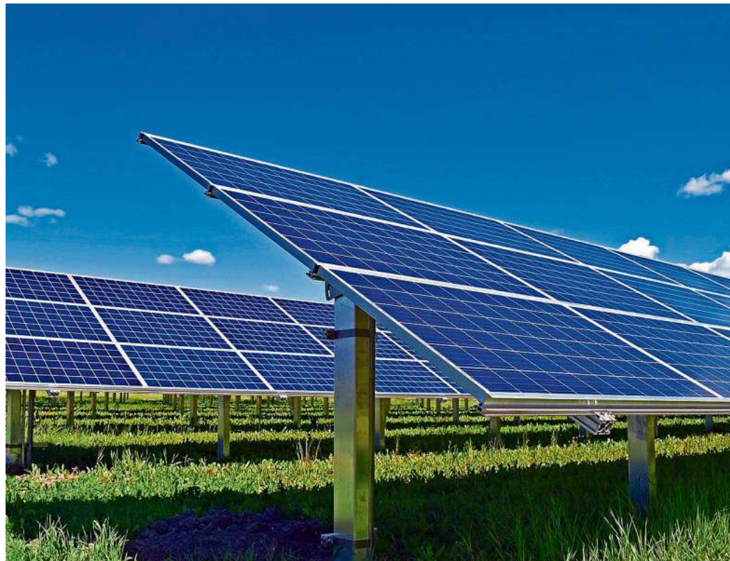
Auf welchen Freiflächen sollen PV-Anlagen errichtet werden? Mit dieser Frage beschäftigt sich der Oberndorfer Technik-Ausschuss. Symbol-Foto: © JRFjin – stock.adobe.com
